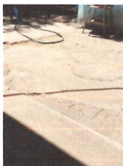
LOSA DE PATIO, REPARACION DE LOSA DE PATIO
